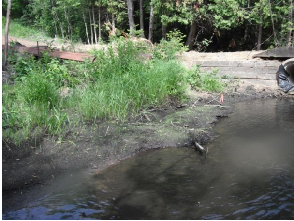
Avant la stabilisation d'une berge ruisseau Trout
